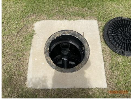
ภาพที่ 2.2-1 ระบบบำบัดน้ำเสียสำเร็จรูป ของครัวเรือน
